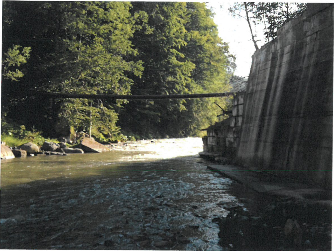
Foto nr. 13 – Degradări ale malurilor, colmatarea și modificări ale traseului albiei râului Jiul de Vest
