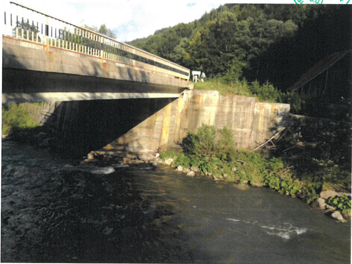
Foto nr. 14 – Albia râului prezintă în amplasamentul podului un traseu sinuos, fapt favorizat de ruperea malurilor care au căzut în albie, afuierea albie cu cca. 1,00 m
